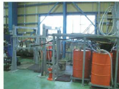
廃油・廃液回収装置による作業
