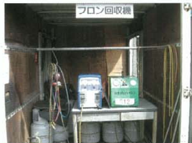
使用済みフロン回収装置による作業
