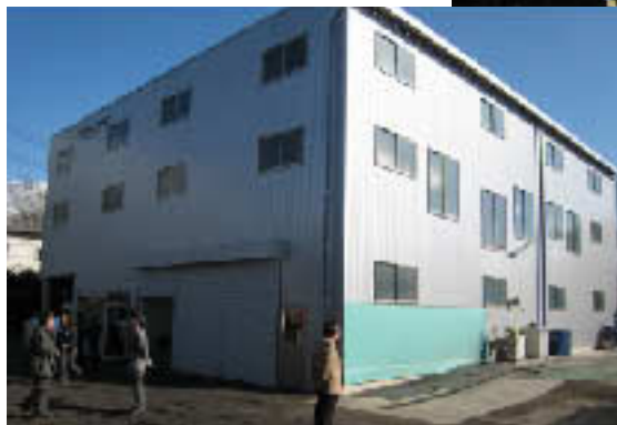
小諸パーツセンター倉庫・事務所
