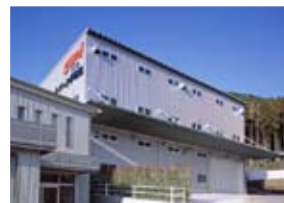
敷地を逐次造成・拡大し、完成した新工場
