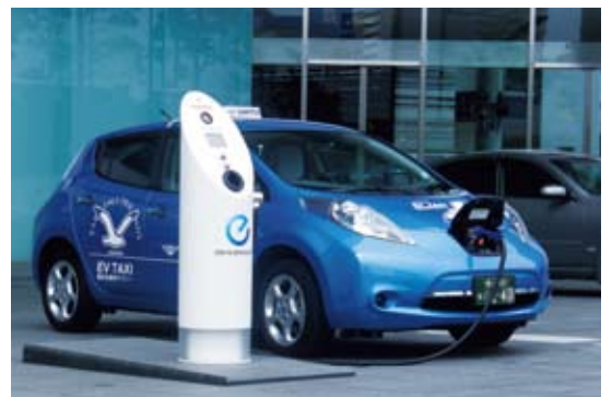
横浜の日産本社前のEV充電スタンド
