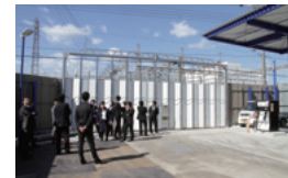
建設中の廃油抜き取り作業場を見学する青年部会メンバー
