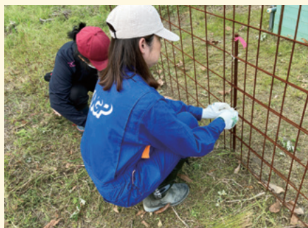
【見学道の植栽地】しごら柵の補修作業
