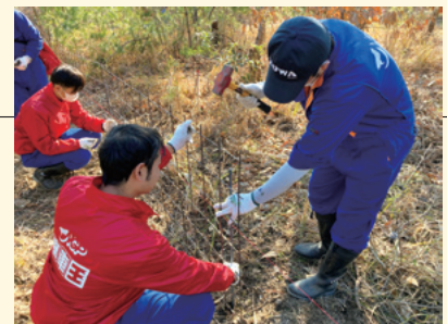
イノシシ対策として金属製ワイヤーメッシュの柵を設置
